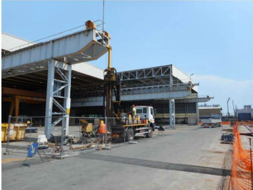
Sondaggio S1, postazione delle attrezzature
