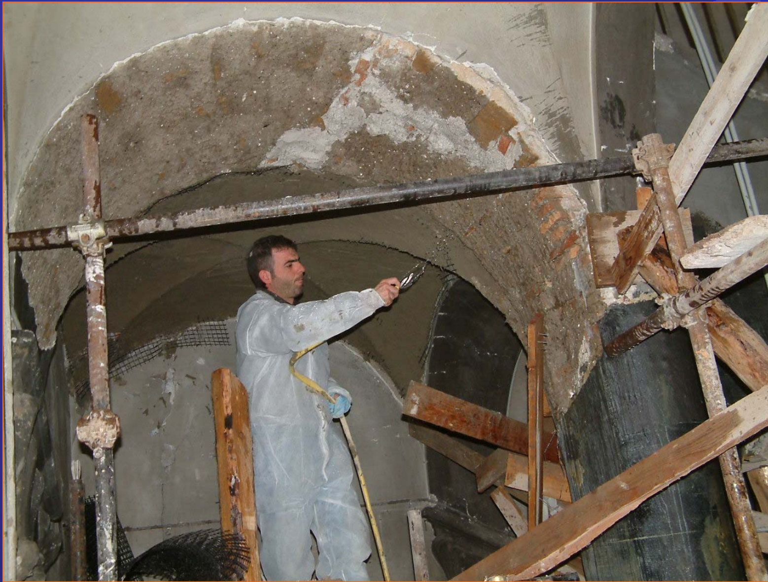
Applicazione all'intradosso di rete in fibra di vetro e malta bicomponente
